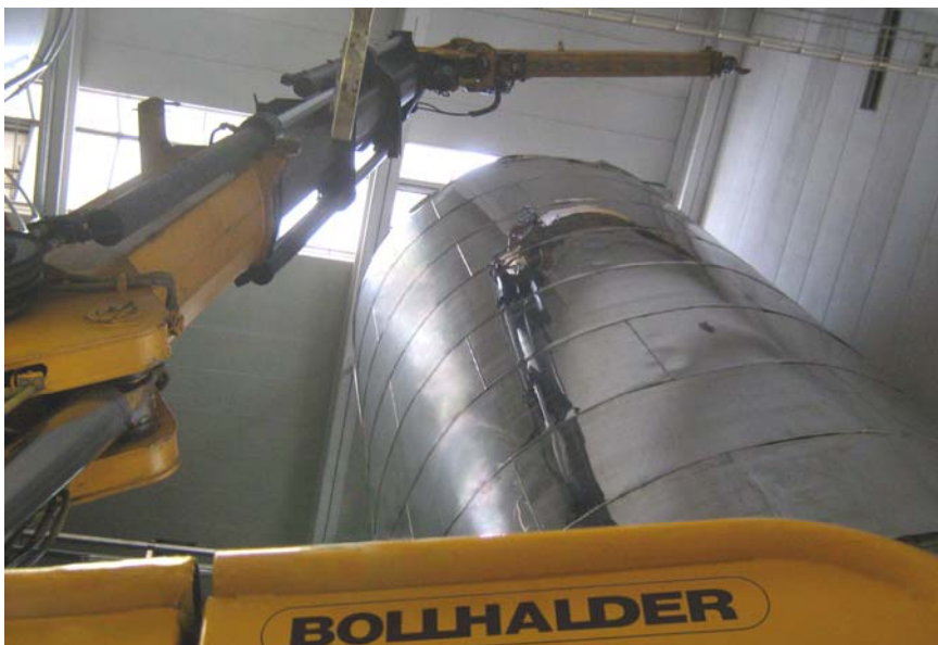
Bakran beim Versetzen des grossen Tanks im Gebäude
